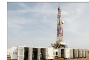
O&G Power Plant 油田电站
